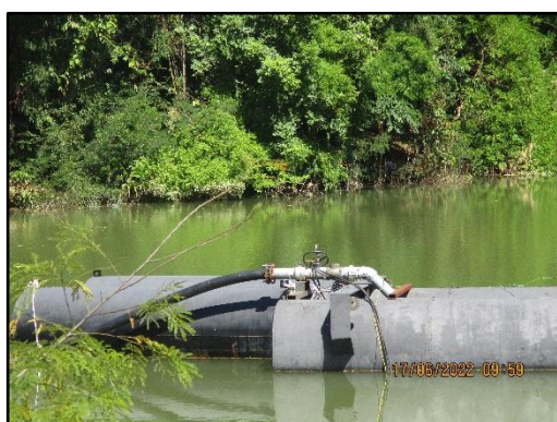
ภาพที่ 2.44 ติดตั้งเครื่องสูบน้ำและวางท่อสูบน้ำ
